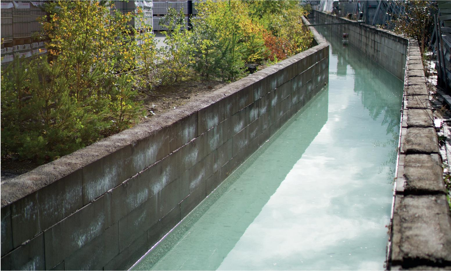
Im „Canale Grande“ werden die Niederschläge vom Werksgelände gesammelt und anschließend für die Herstellung neuer Steine genutzt.
