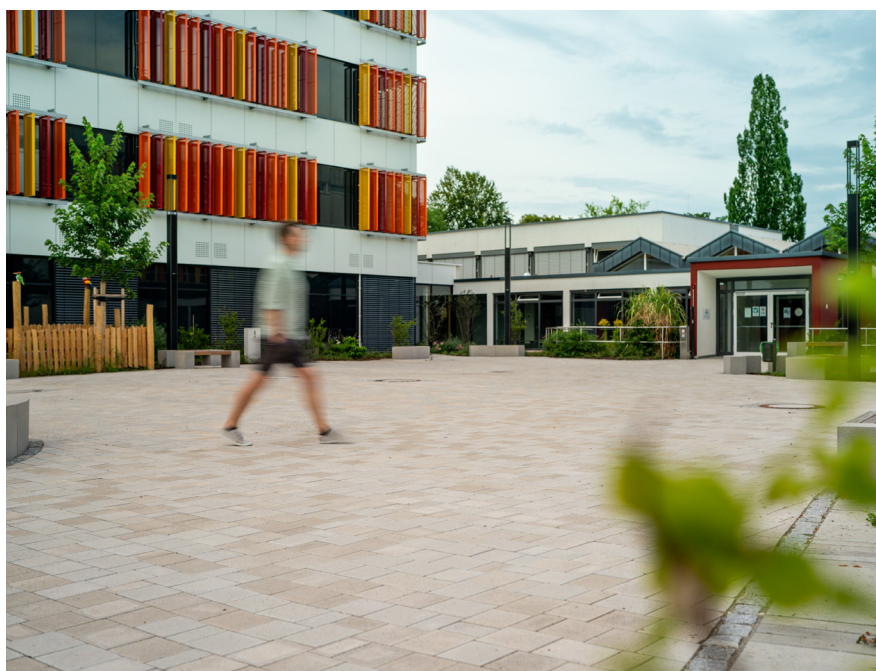
Le revêtement est posé en quinconce. Cela souligne le caractère naturel du GDM.KLIMASTEIN, qui favorise l'évaporation.
