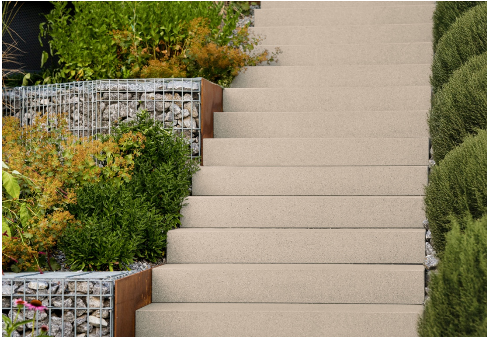
Stufenelemente aus GDM.LIVA als Bestandteil eines durchgängigen Gestaltungskonzepts für den Außenraum
