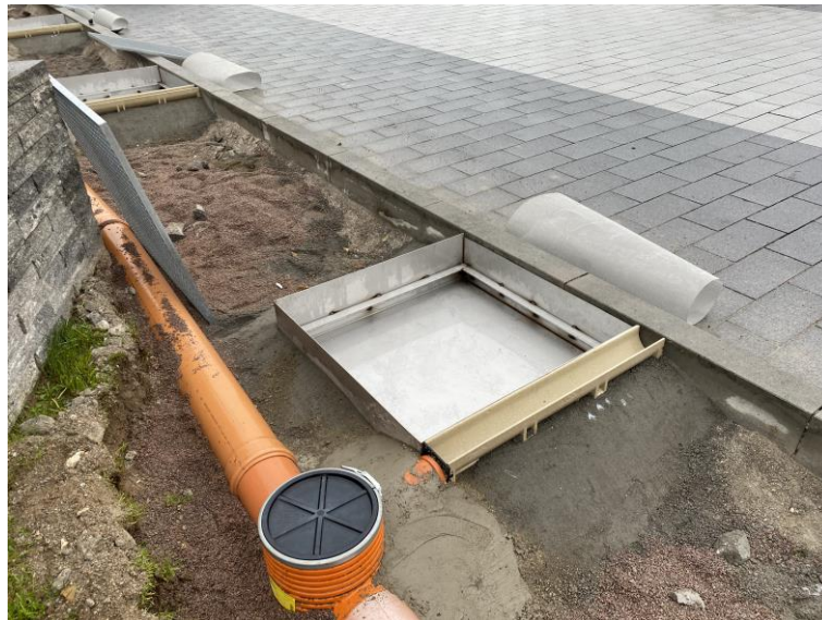
Abbildung 3: Einbau der Lysimeterwanne und des Messschachtes
