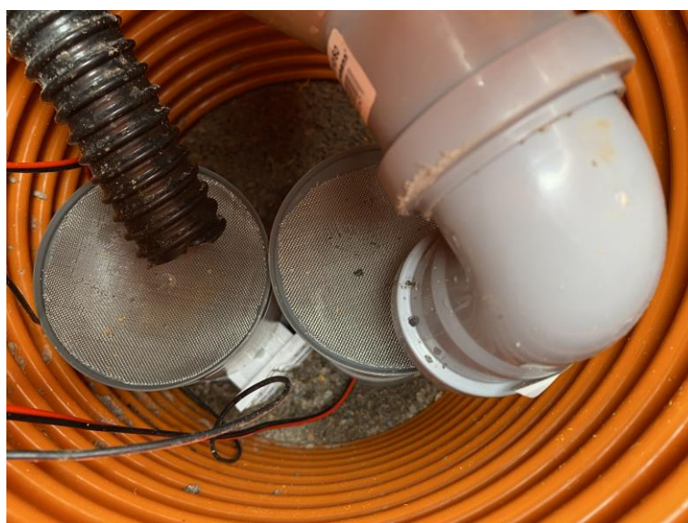
Abbildung 4: Einbau der Kippzähler
