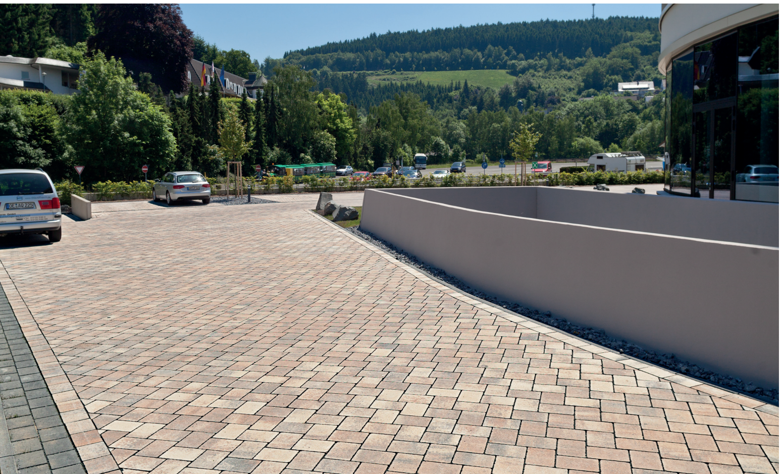
Fischgrätverband, geeignet bis Belastungsklasse Bk3,2
