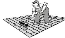
Für einen filterstabilen Fugenaufbau wird eine Gesteinskörnung gem. TL Gestein-StB 1/3 mm vorgegeben. Der Widerstand gegen Schlagzertrümmerung sollte ebenfalls einen Wert  $\leq SZ_{22}$  aufweisen.
