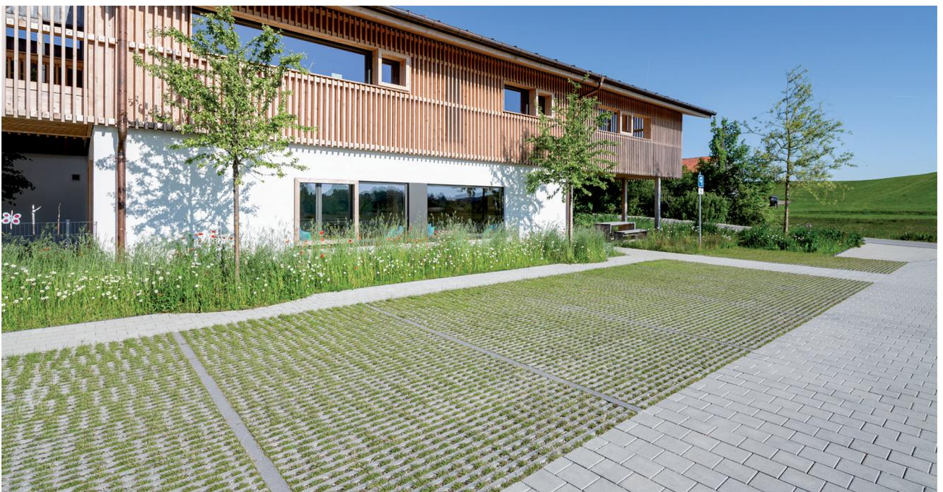
GDM.SCADA liner 5-5 proActive 40/40/12 cm und 40/20/12 cm mit 42 mm Fuge, nativo, Grau, proDrain, proPower 4
