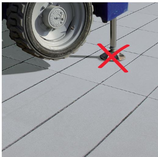
Abb. 86: **FALSCH: LASTVERTEILUNG ÜBER NUR EINE PLATTE!**
