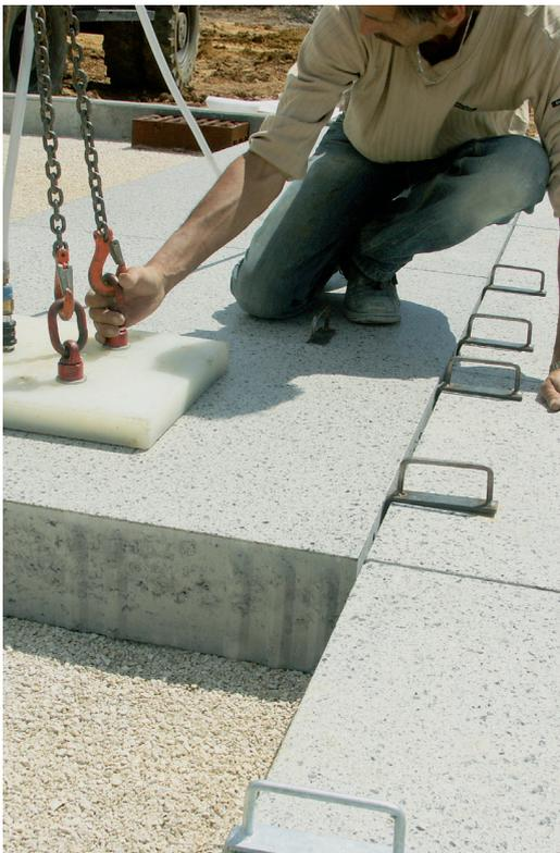
Abb. 82: Aufsetzen von Großformaten mit dem Vakuumgerät auf die Bettung
