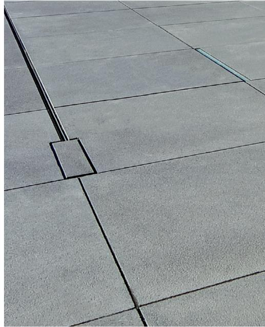
Abb. 92: Einbindung einer Schlitzrinne in den Plattenbelag
