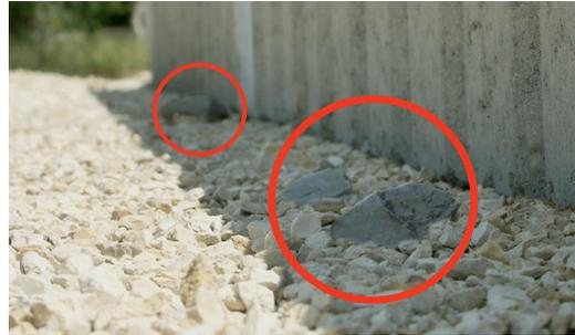
Abb. 79: Kornanteile aus der Tragschicht in der Bettung können zu Schäden führen
