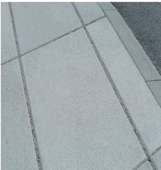
Abb. 100: Randanschluss durch Sonderbauteile mit Scheinfuge
