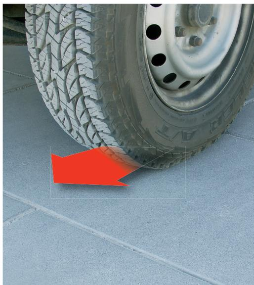
Abb. 59: Radaufstandsfläche auf einer Platte mit auftretenden Horizontalkräften
