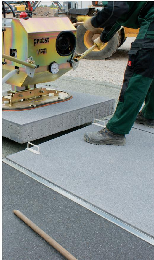
Abb. 80: Verlegung von Großformaten, 1200 x 1200 x 160 mm, mit Fugeneisen
