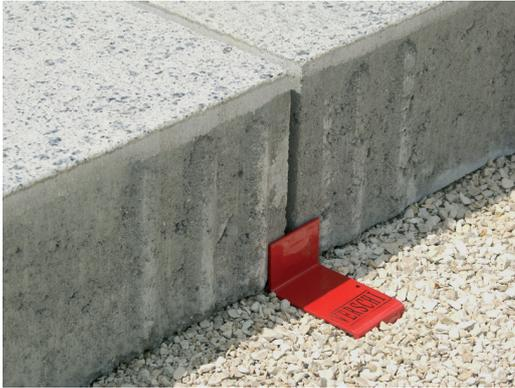
Abb. 87: Montage des Verschiebeschutzes/Abstimmung der Position zum Verzahnungssystem
