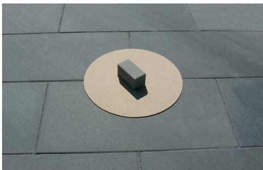
Abb. 104: Ermittlung der Passtücke mit einer Schablone
