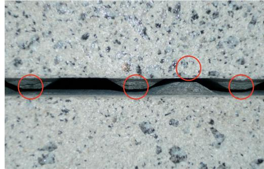
Abb. 96: Auch bei Verzahnungssystemen gilt: Pressverlegung unbedingt vermeiden!
