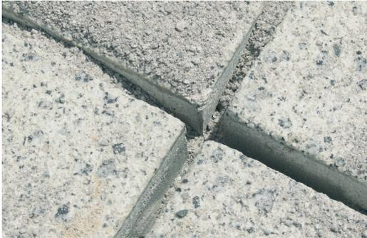
Abb. 94: Füllen der Fugen mit trockenem, den vorgeschriebenen Sieblinien entsprechendem Material
