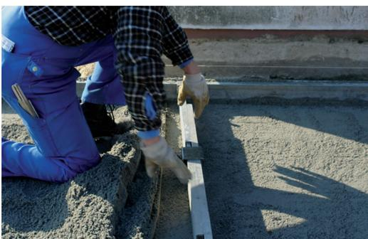
Abb. 78: Bettung aus Splitt-Sandgemisch 0/4, Dicke 20-40 mm (im Mittel 30 mm)
