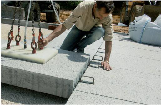
Abb. 81: Verlegung von Großformaten mit Vakuumgerät
