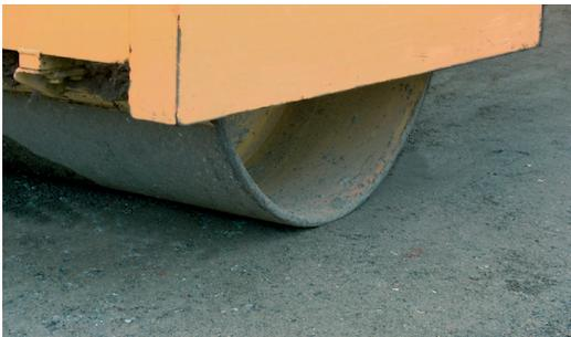
Abb. 77: Verdichten der obersten Tragschicht mit einer Walze (statische Verdichtung)
