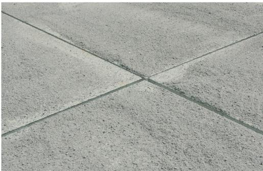
Abb. 95: Fugenmaterial auf der zu befüllenden Fläche zum Trocknen ausbreiten.
