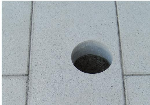
Abb. 106: Einfassung durch Bohrung
