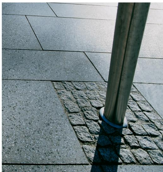
Abb. 107: Einfassung durch Umpflasterung
