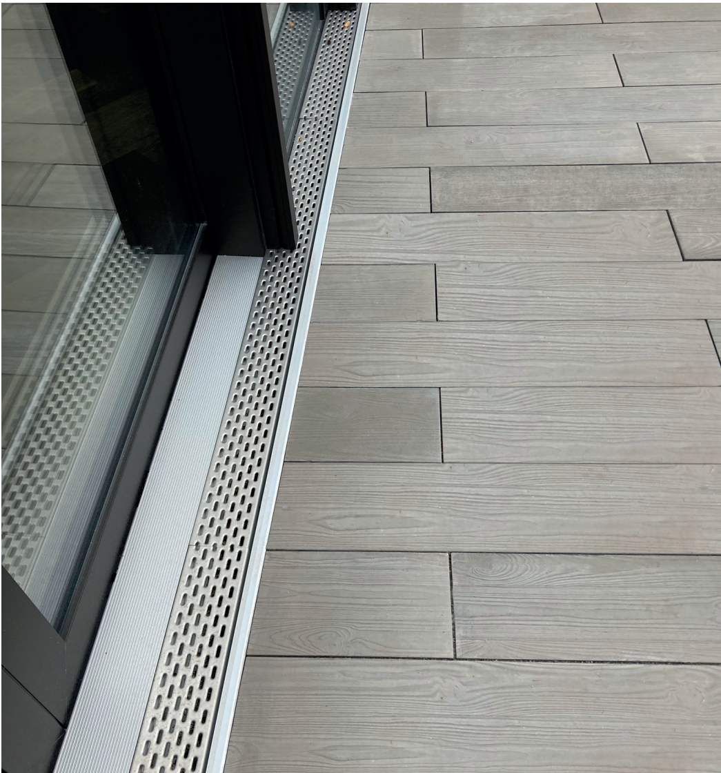
Randbereich mit Einfassung aus Edelstahl und Ablaufrinne zur Entwässerung
