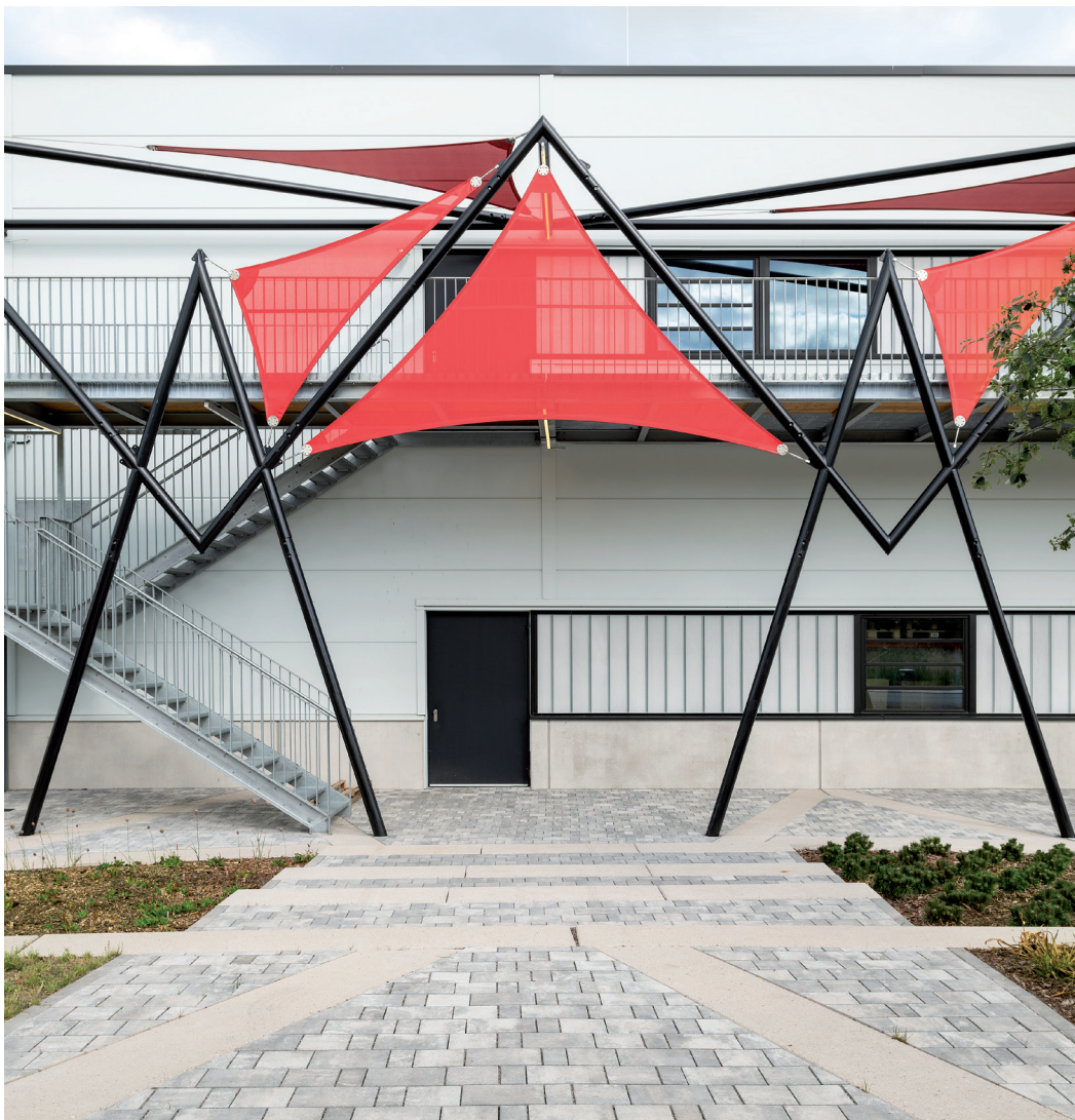
Camina-Halle, Neubau Produktionsstandort | Rathenow
