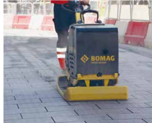
Abb. 59: Flächenrüttler mit Kunststoffschürzen verwenden
