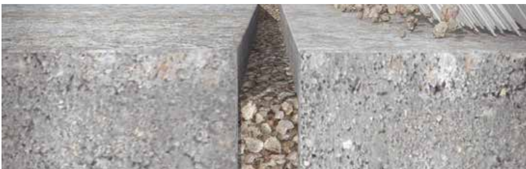
Abb. 66: Auffüllen/Einfegen mit neuem Fugenmaterial bis Oberkante Fuge
