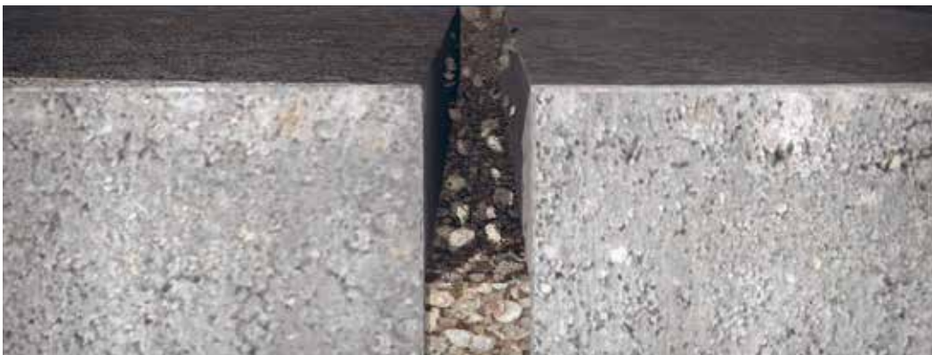
Abb. 65: Ausspülen und Absaugen des oberen (2-3 cm) verunreinigten Fugenmaterials
