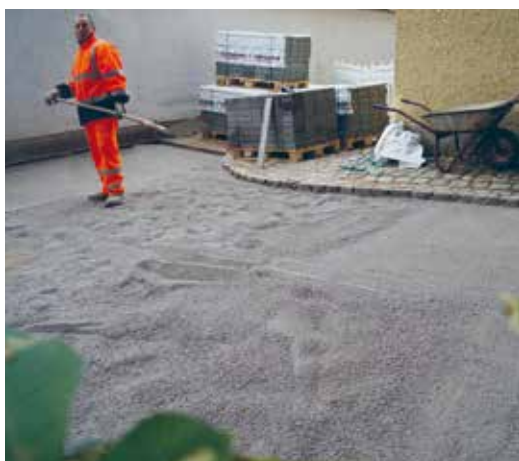
Abb. 57: Einbringen des Bettungsmaterials
