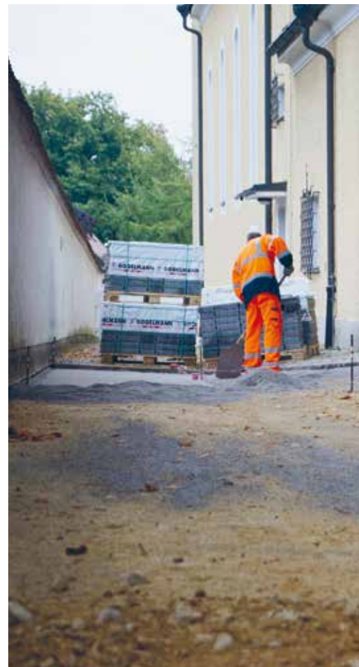
Abb. 52: Der erste Spatenstich muss gut vorbereitet sein
