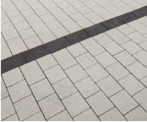
Abb. 58: Fugen immer vollständig verfüllen!
