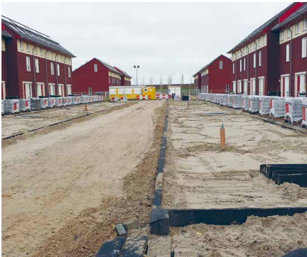
Abb. 56: Für den weiteren Aufbau müssen die Schichten sorgfältig planiert werden
