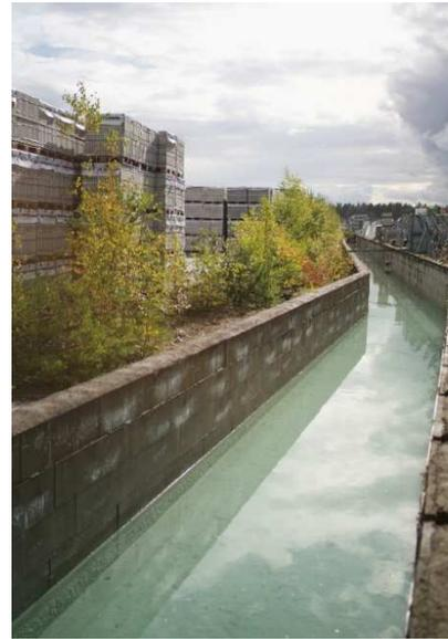
GODELMANN Standort Fensterbach: Photovoltaikanlagen auf den Hallendächern (li) und das ausgeklügelte Kanalsystem, das ganzjährig Niederschlags- und Abflusswasser sammelt (re).
